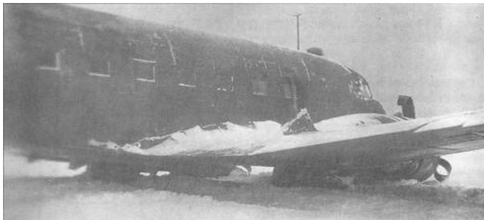
Вынужденная посадка ПС-84 транспортного отряда НКАП у станции Дема под Уфой, ноябрь 1941 г. Самолет, эвакуировавший рабочих моторного завода из Рыбинска, обледенел в полете и приземлился на замерзшее болото
